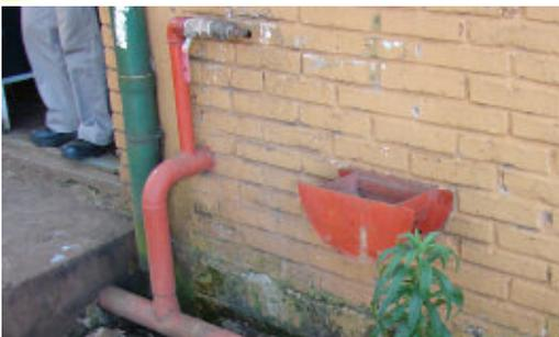
Ambos sistemas estarán identificados mediante colores normalizados (Norma IRAM 2507. Sistema de seguridad para la identificación de cañerías), y no deberán existir interconexiones entre ellos. Las conexiones para mangueras, las llaves de agua y otras fuentes similares de posible contaminación deberán estar diseñadas de tal manera que se prevenga el contraflujo y sifonaje de aguas residuales al agua potable.
