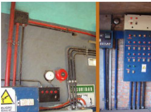
Las instalaciones eléctricas deberán ser empotradas o exteriores, en este caso estar perfectamente recubiertas por caños aislantes, adosados a paredes y techos. Los controles, centros de distribución, paneles o tableros u otros equipos eléctricos deberán mantenerse cerrados y sus protecciones colocadas.
